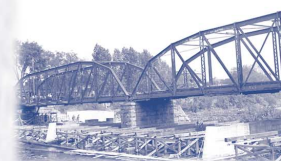
Démolition et construction, 1949
